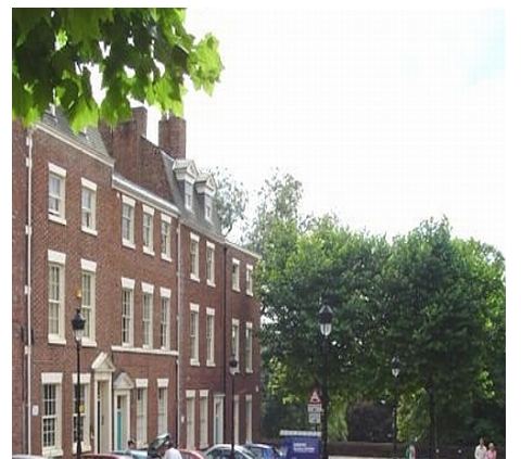
EINES DER BEIDEN SCHULGEBÄUDE
