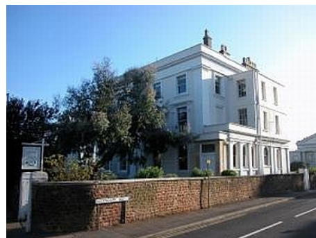
DAS HAUPTGEBÄUDE DES ELC BRISTOL
